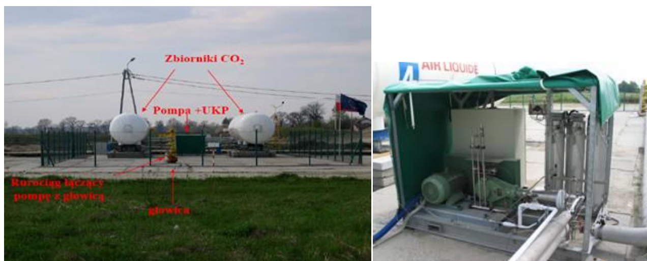
Fig. 1.1.33_6 Widok instalacji i zbiorników do zatłaczania CO 2 (po lewej) oraz (po prawej) pompa, silnik, podgrzewacze, rurociągi doprowadzające i odprowadzające CO 2
