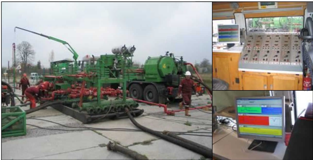
Fig. 1.1.33_12 Zabieg hydroszczelinowania trzech pokładów węgla w otworze MS-3 (ZRG Krosno)
